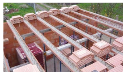
Obr. 3 Kladení vložek na předem podepřené trámy
